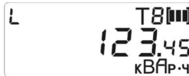
Рисунок Д.9.2 - Пример индикации текущих показаний реактивной энергии (индуктивной) (текущий тариф по активной энергии– 8) (РиМ 181.05-К, РиМ 181.06-К, РиМ 181.09-К, РиМ 181.10-К)
